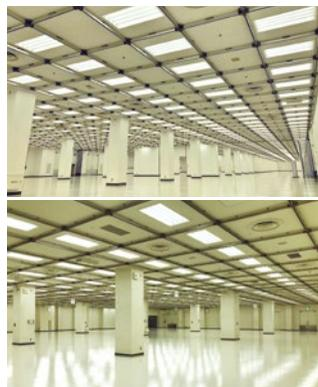
2020年8～10月にかけて、温室効果ガスの削減を目的に、第一展示場及び第二展示場の照明器具の更新工事(LED化)を実施しました。第一展示場の照明器具(FHF32W×4灯用) 868台、第二展示場の照明器具(FHF32W×4灯用他) 803台のLED化により、年間の展示場照明器具に対する電気使用量を43%削減することが可能となりました。
