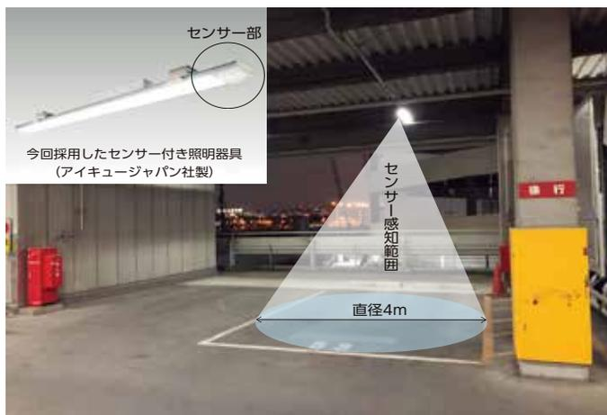
2021年11月～2022年3月にかけて、温室効果ガスの削減を目的に、第二立体駐車場の照明器具の更新工事(LED化)を実施しました。今回更新工事にあたり適正照度(JIS照度基準:30lx程度)を勘案し、照明器具台数を602台⇒407台へ削減。また、車室内(246台分)をセンサー付き照明器具とすることで更なる省エネ対策を計画し、計算値上では年間の電気使用量を75%(54.7t-CO<sub>2</sub>)削減(※)できる見込みです。(※)今後実測値にて実際の削減量について確認予定です。
