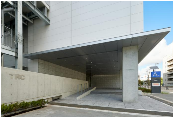
▲エントランス（外観）
