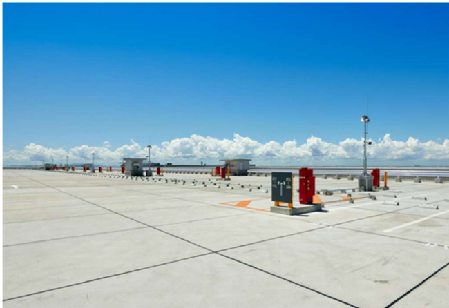
【A棟屋上駐車場】
